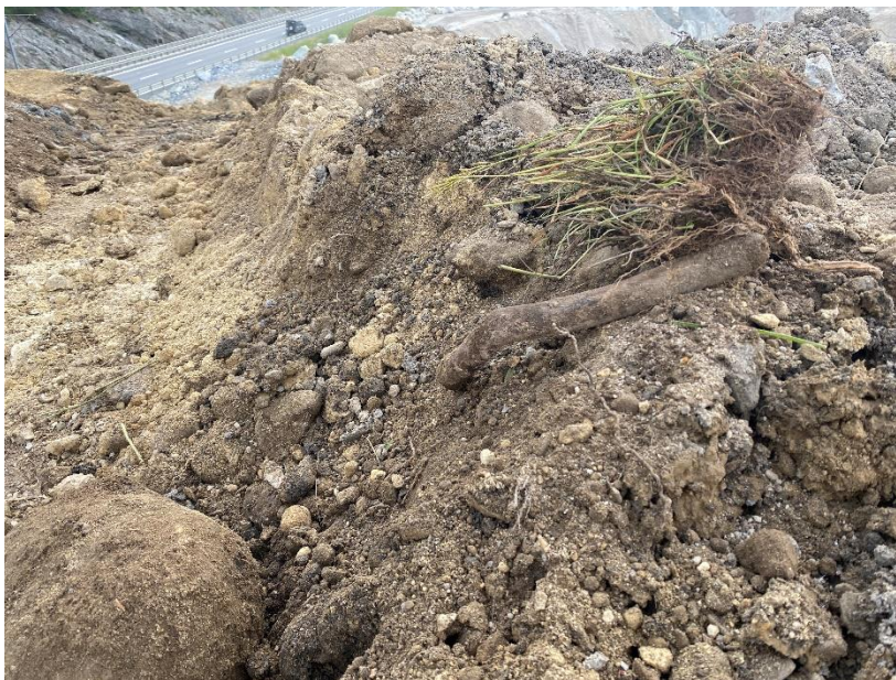
Abbildung 1: Lokal stark organisches Aushubmaterial mit Oberbodenmaterial und Holz
