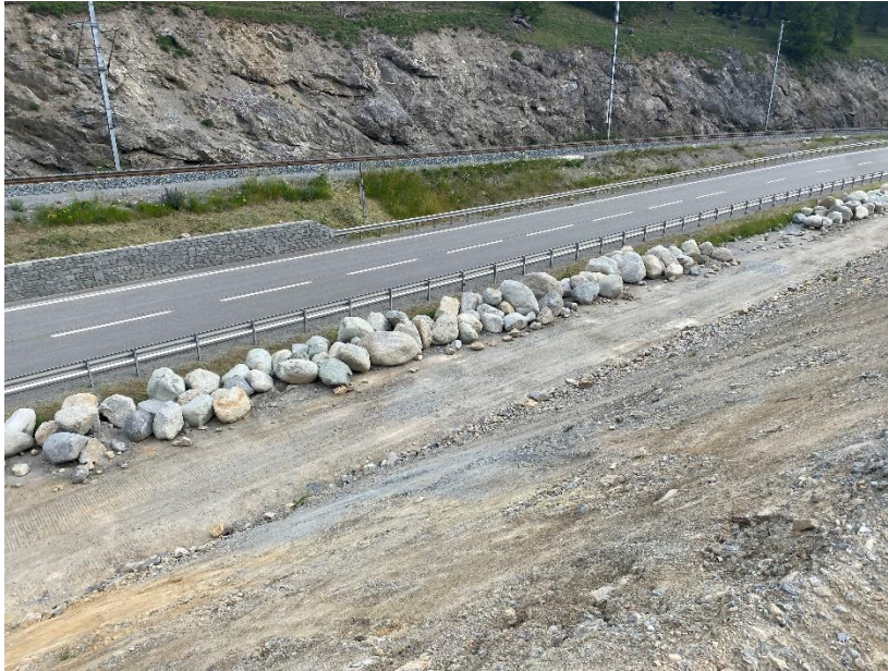
Abbildung 2: Für die Befestigung der Böschung vorgängig separierte Blöcke
